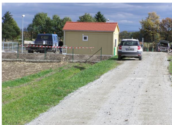
↑ Příjezdová komunikace k ČOV
