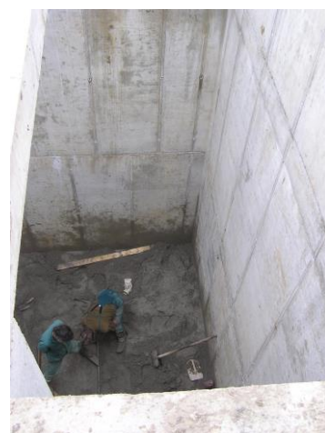
Úprava dna šterbinové nádrže
