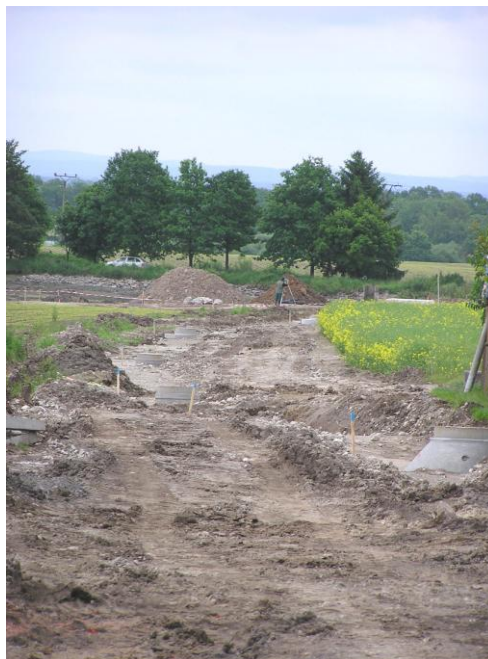
Dokončená kanalizace k ČOV – budoucí komunikace
