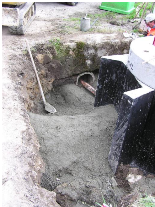
Propojení stávající výusti V1 do nové kanalizace
